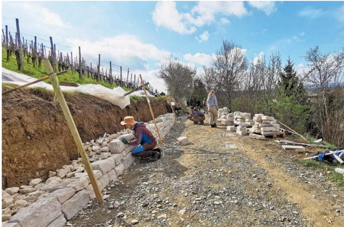
Die Zivis arbeiten fleissig an der rund 20 Meter langen Trockensteinmauer in den Rebanlagen von Stefan Wettstein. Bild: jbe
