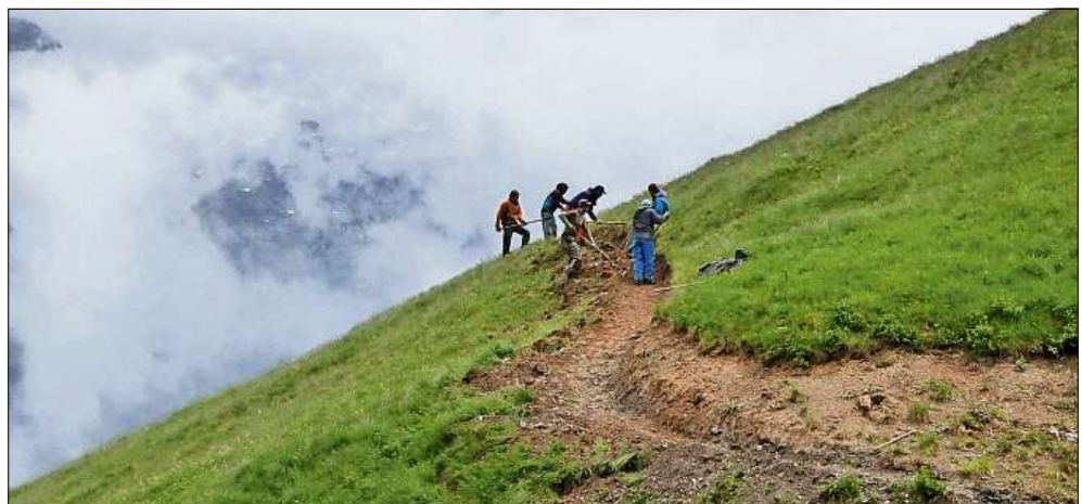
Nach einem Regenguss wird der Weg ins Gelände eingepasst.
