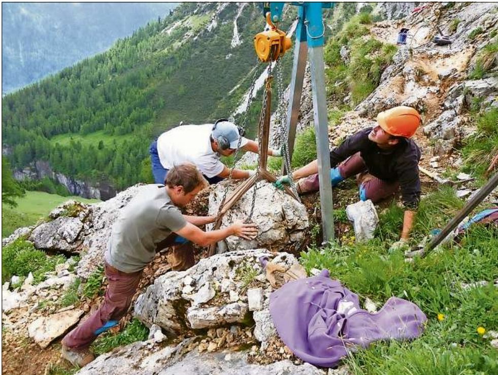
Anstrengend: Mit dem Vierbeinkran wird ein grosser Stein als Treppenstufe in den Wanderweg eingefügt.
