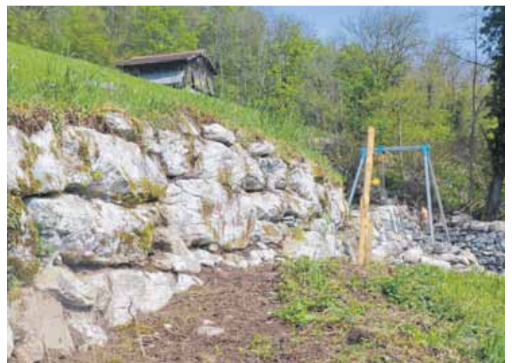
Frisch wiederhergestellte Trockensteinmauer
