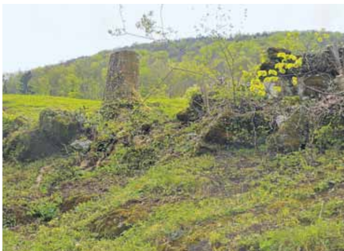
Verbuschte Trockensteinmauer vor der Sanierung
