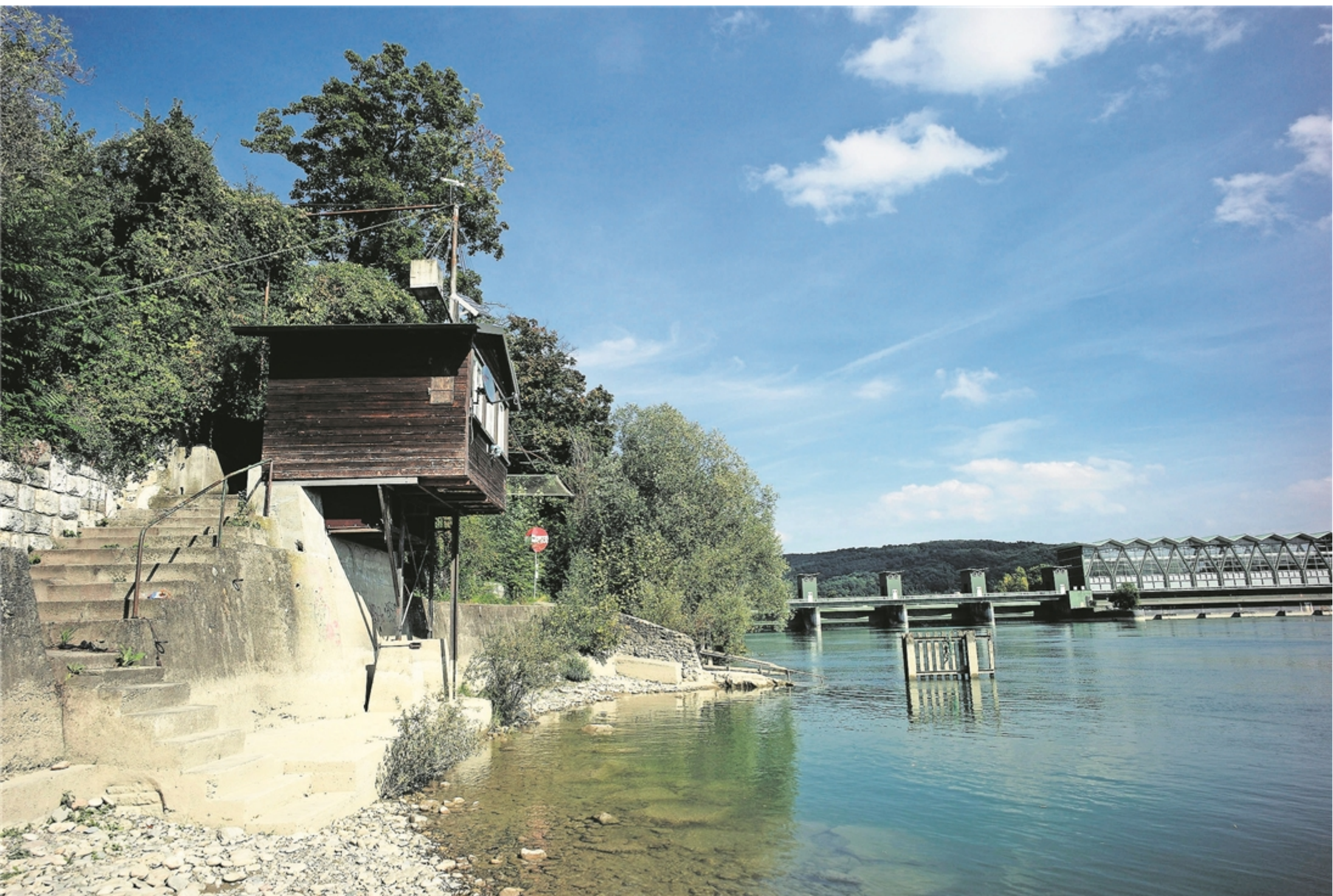
Fischergalgen im ältesten Naturschutzgebiet der Schweiz, der Rheinhalde auf Höhe des Grenzacherwegs.
